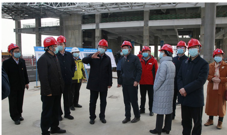
高体健一行实地查看新馆施工情况
